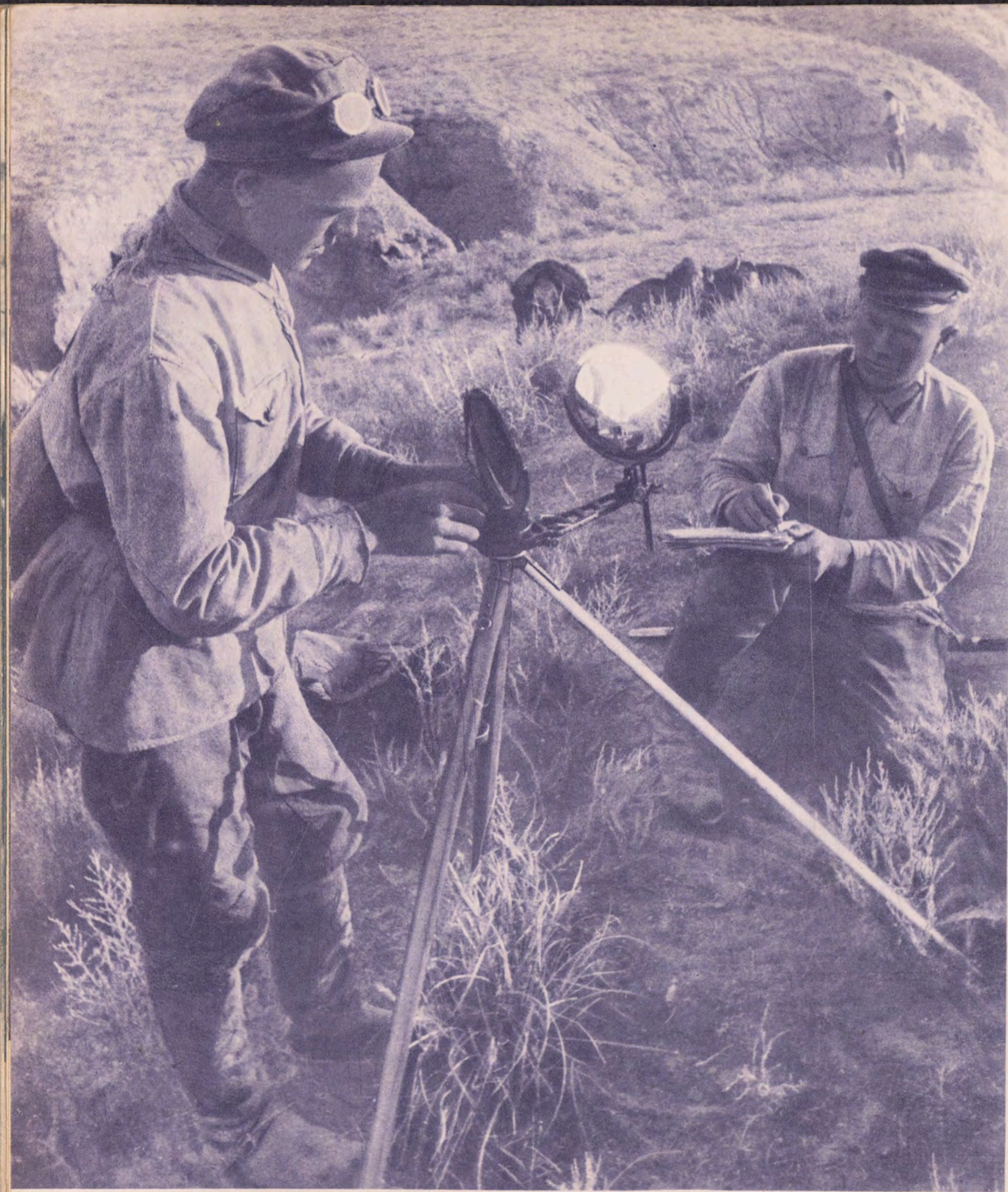
СВЕТОВАЯ СВЯЗЬ. ГЕЛИОГРАФ В РАБОТЕ.
